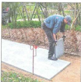
Wenn möglich, packen die Vereinsmitglieder bei Umbaumaßnahmen selber mit an.
